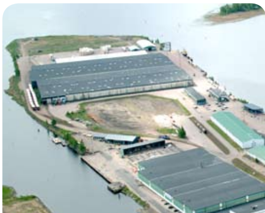
Området innan anläggning av den nya containerterminalen
